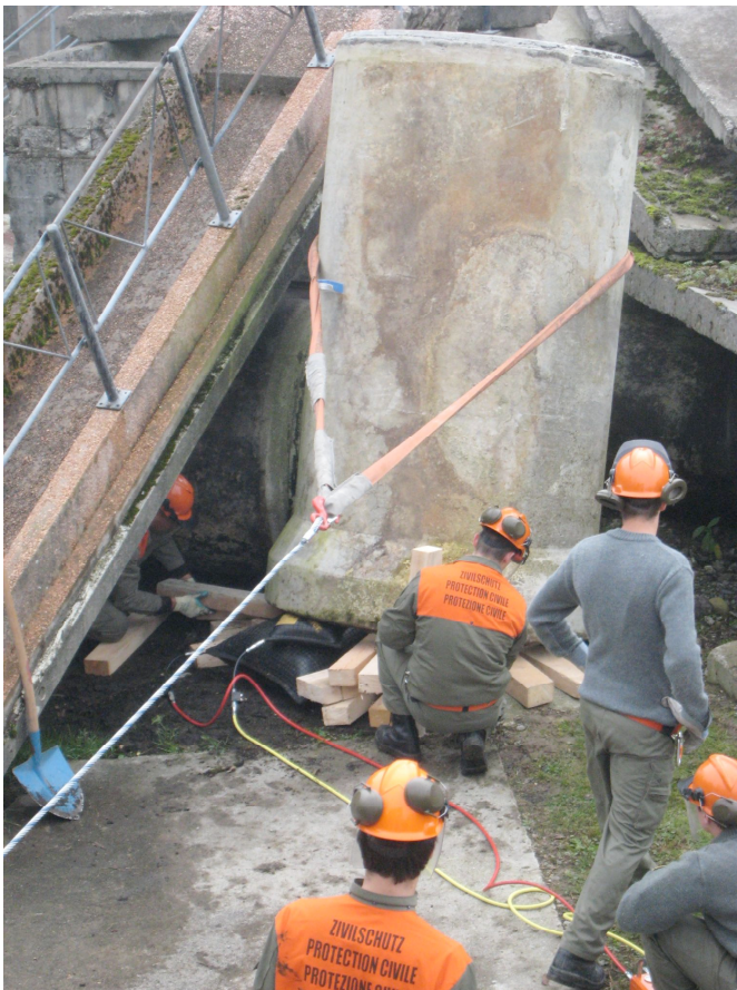
Zivilschützer heben ein Betonrohr an, um eine verletzte Person zu bergen.
