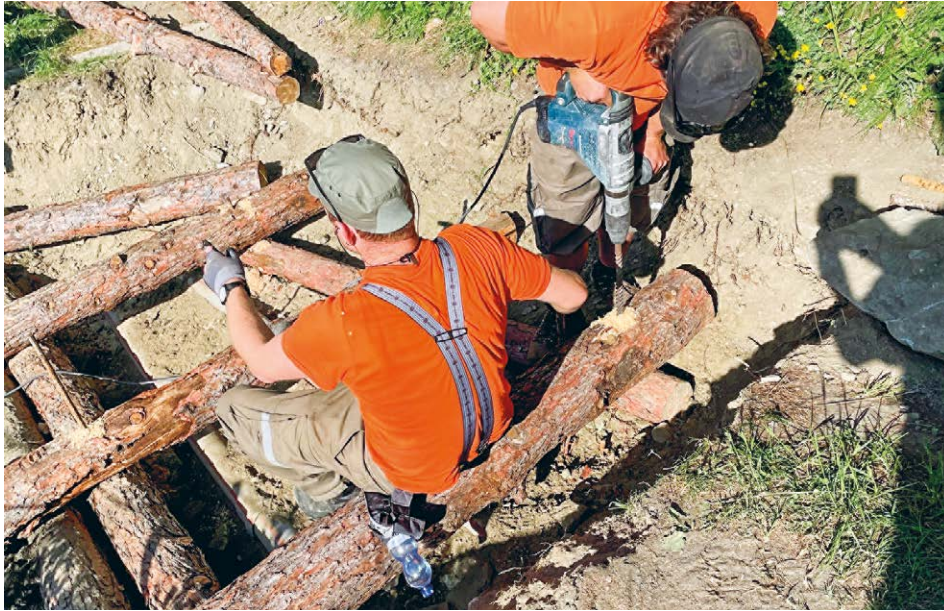
Mit Holzstämmen erstellten die Zivilschützer einen Unterbau, der danach mit Schutt und Erde aufgefüllt wurde.
